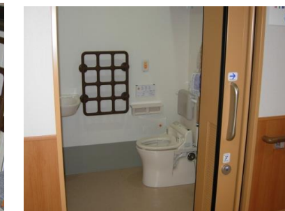
共同生活室トイレ
